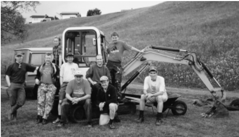
Mit grobem Werkzeug, aber auch viel Handarbeit, wurde der KTV-Badeplatz ausgebaut.
