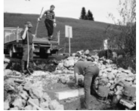
Auch die Treppe zum Sihlseeufer wurde erneuert.
