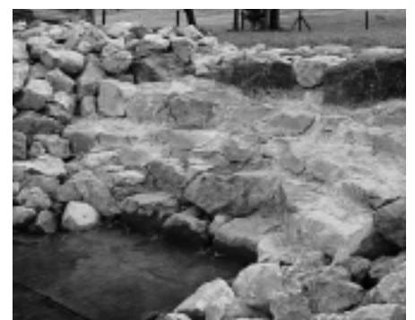
Auch die Treppe zum Sihlseeufer wurde erneuert.
